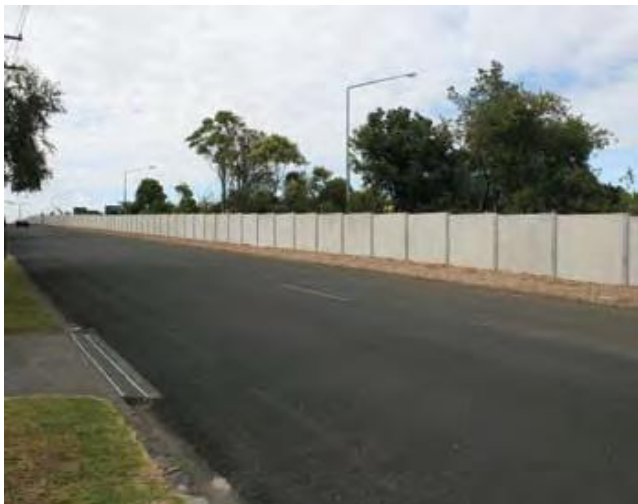
Ilustración 24: Paneles de hormigón premoldeado (13)
