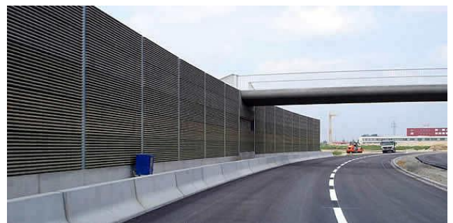
Ilustración 27 Barrera sónica de hormigón con protección de New Jerseys
