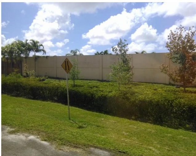
Ilustración 8: Barrera sónica de hormigón blanco
